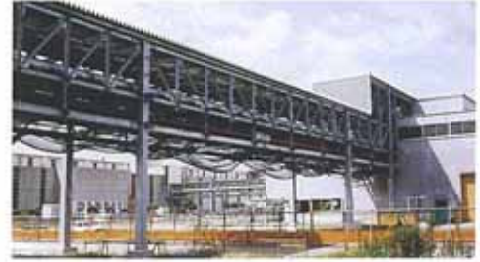
トヨタ自動車㈱田原 3E工場 スタンション (鉄骨)
