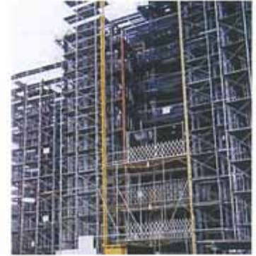
アイシン㈱AW 豊橋寮新築工事 (鉄骨階段)
