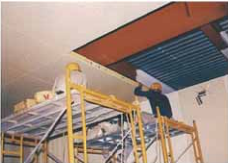
リングハット㈱冷蔵庫新設工事 防熱パネル組立工事 Installation of refrigeration system for Ringahatt Co., Ltd. Installation of heat insulation panels
