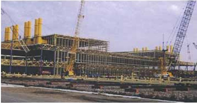
トヨタ自動車㈱九州工場 新築工事 清水建設㈱施工 (煙突及び床鉄板貼り)
