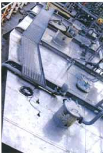
プロピレンタンク防熱工事 Heat insulation of propylene tank
