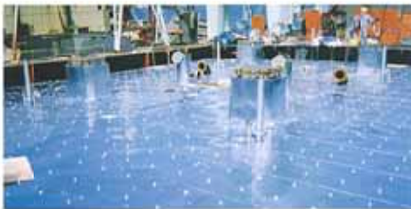
アスファルトタンク防熱工事 Heat insulation of asphalt tank
