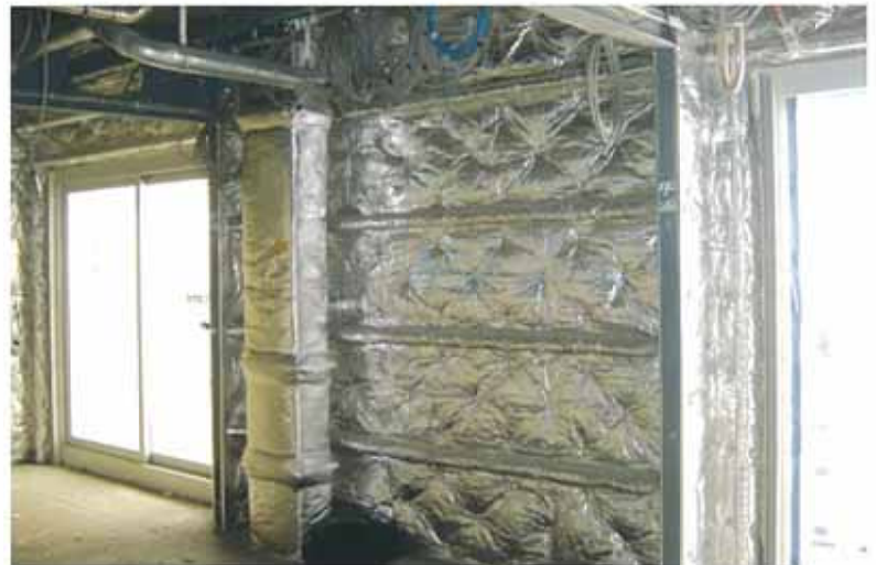
一般防熱 Heat insulation
