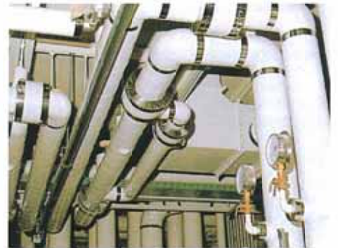
機械室パイプ防熱工事 Heat insulation of machine room piping
