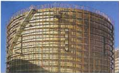
タンク防熱工事 Heat insulation of storage tank
