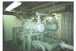
スクリー型チラーユニット Screw type chiller unit
