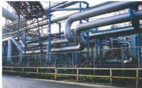
パイプ防熱工事 Heat insulation of piping
