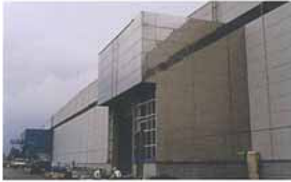
関ソノイケ製作所 新築工事 清水建設㈱施工 (壁ステンレスパネル弊社施工)
