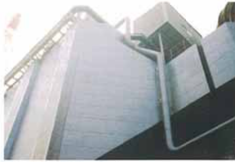
三菱重工業㈱向け集塵装置保温工事（住友金属和歌山工場） Heat insulation of dust collection system for Mitsubishi Heavy Industries, Ltd (Sumitomo Metal Industries, Ltd., Wakayama Plant)
