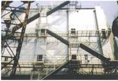
三菱重工業㈱向け集塵装置保温工事（住友金属和歌山工場） Heat insulation of dust collection system for Mitsubishi Heavy Industries, Ltd (Sumitomo Metal Industries, Ltd., Wakayama Plant)
