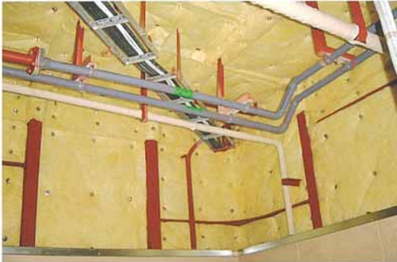
一般防熱 Heat insulation
